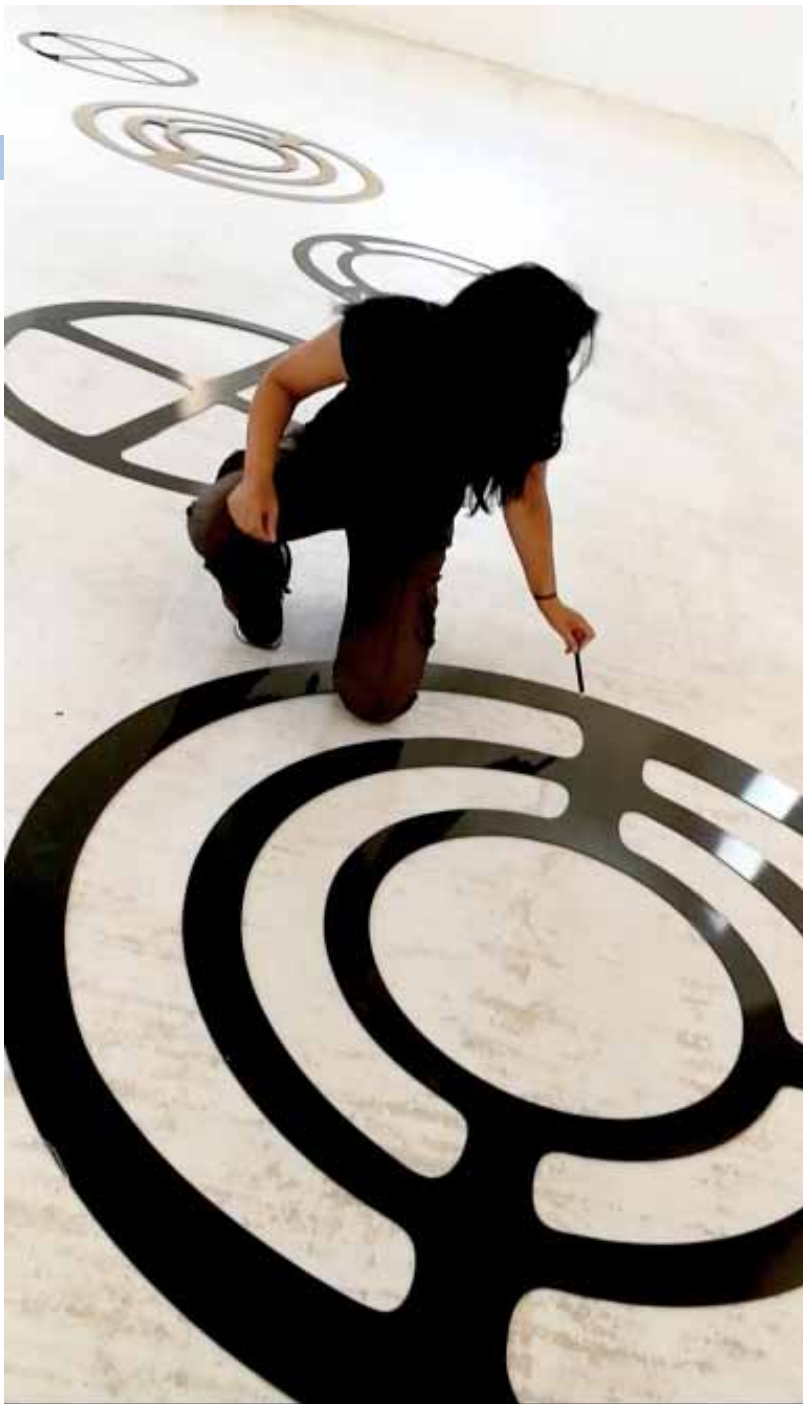
acciaio verniciato pavimento Masseria Calderisi Savelletri (fase di montaggio) 2018
